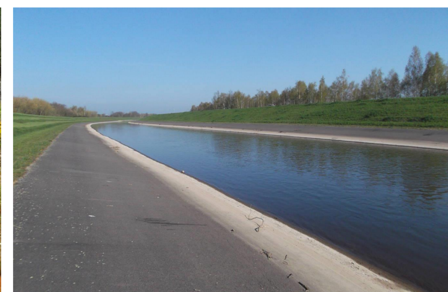
Abbildung 4: Weiße Elster zwischen Zwenkau und Hartmannsdorf. Der Ausbau des Flusslaufs, umgangssprachlich „Betonester“ genannt, erfolgte im Zuge der Erschließung der Braunkohletagebaue.
