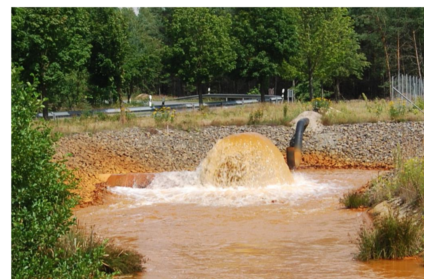
Abbildung 3: Fassung von Sumpfungswässern. Mit dem Anstieg des Grundwasserspiegels und dem Anschluss des Grundwassers an die Fließgewässer gerät deren Verockerung aufgrund von Stoffeinträgen in den Fokus.
